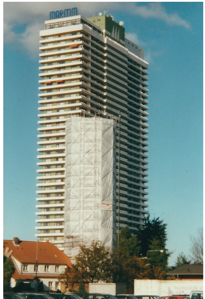
Die Verkleidung des Leuchtturms erfolgte um 2002. Alle Fotos: Archiv Rolf Fechner
